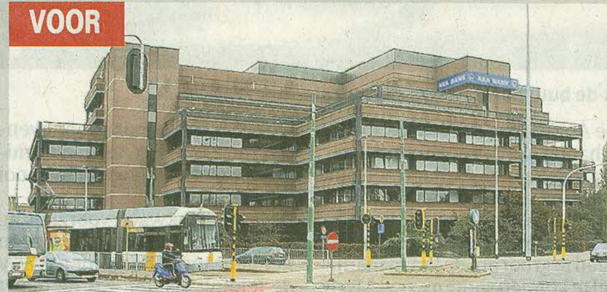
Het oude bruine gebouw. Foto Kos
