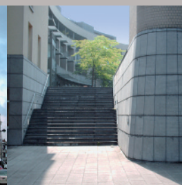
Brasschaat, Politiekantoor: gevel- en vloerdelen in natuursteen met ThefAPP® tegen omgevingsvervuiling beschermd
