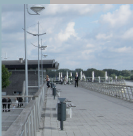
Boom, Esplanade: betonnen wanden met Anti-Graffiti coating 'PSS 20'® tegen graffiti beschermd
