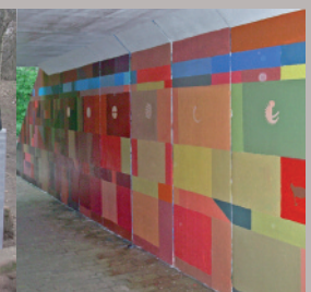
Louvain-la-Neuve, onderdoorgangen bij het meer: met Anti-Graffiti coating 'PSS 20'® tegen graffiti beschermd
